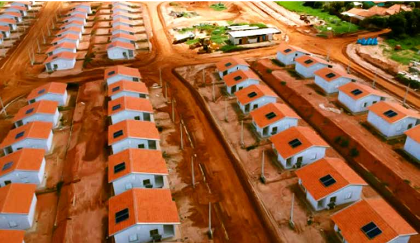
Na cidade de Estrela d'Oeste, a CDHU já entregou 781 moradias, incluindo as 116 unidades habitacionais desta entrega
