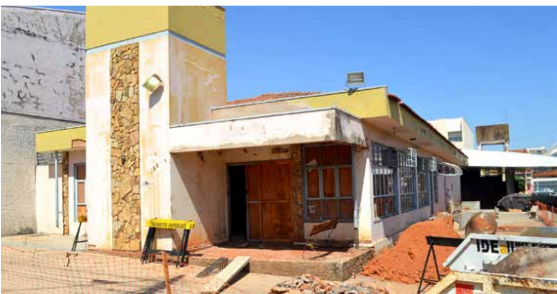
Local começa a receber serviços de melhorias e reformas
