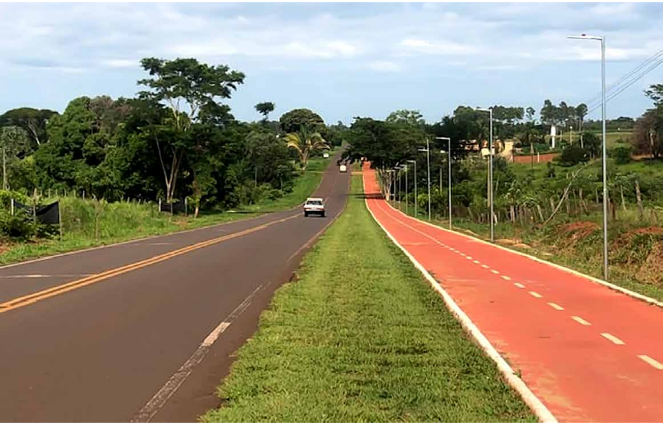
Obras em ciclovía de Ouroeste foram concluídas
