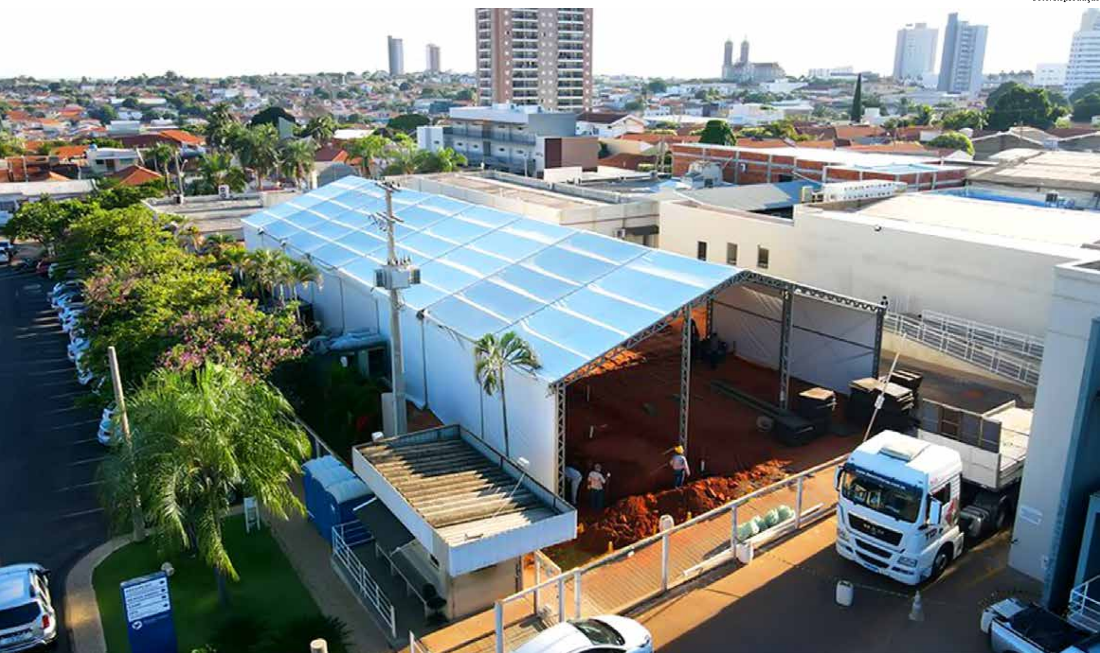
Hospital de campanha sendo construído em Votuporanga
