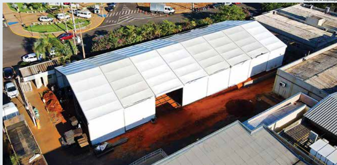
Hospital de Campanha em Votuporanga: instalação no estacionamento da Santa Casa
