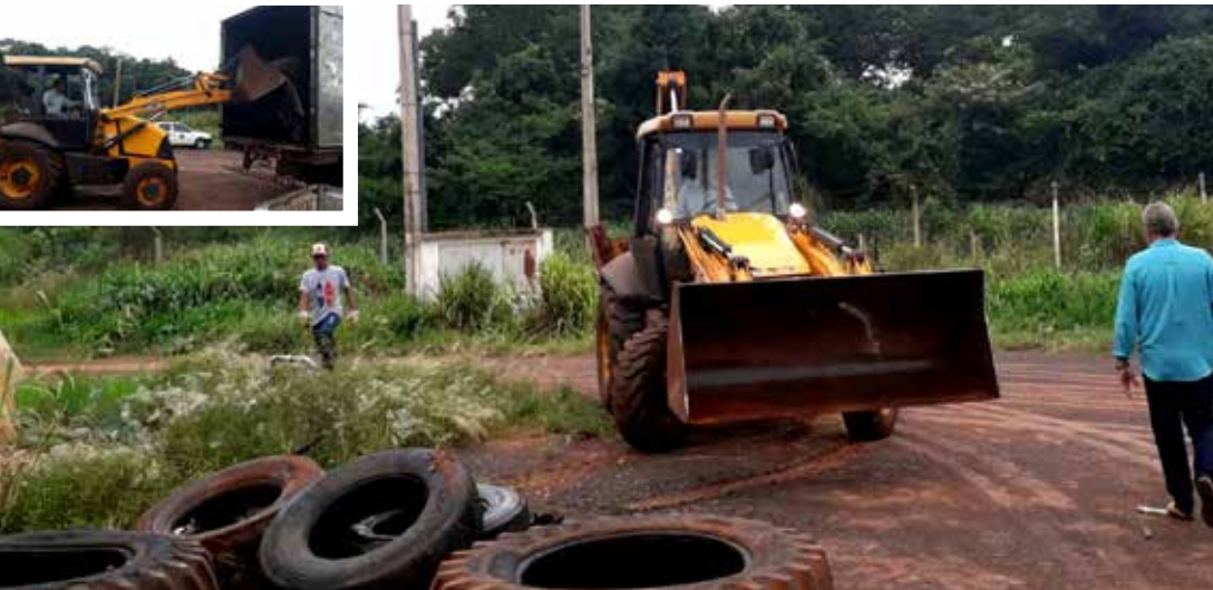
Uma das formas de reaproveitamento dos pneus inservíveis é como combustível alternativo para as indústrias de cimento
