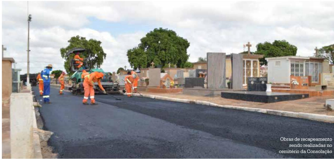
Obras de recapeamento sendo realizadas no cemitério da Consolação
