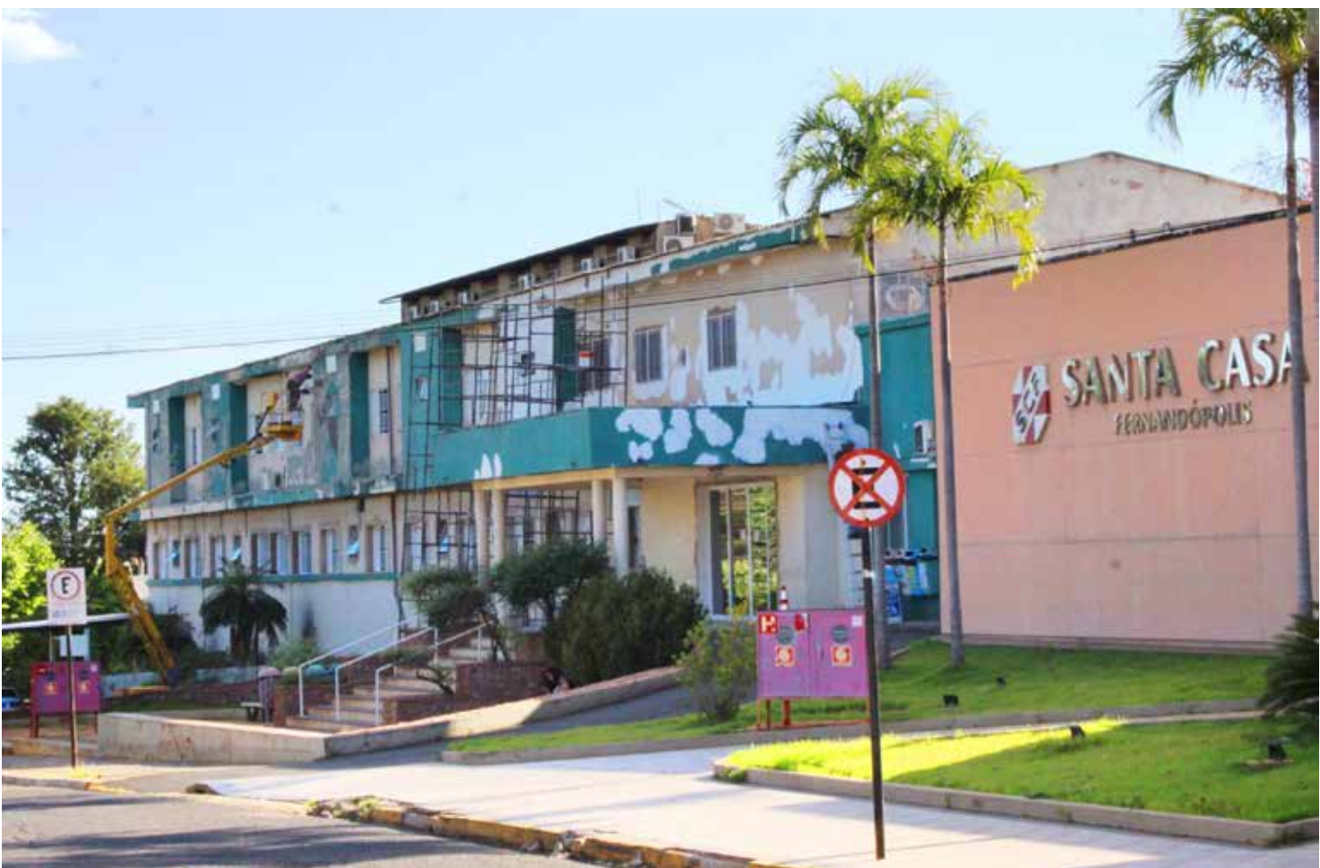
Serviços de restauração de parte da fachada da Santa Casa estão em andamento graças a repasse de verba da Sabesp. Em 2007, quando a prefeitura renovou por 30 anos a concessão para exploração do saneamento básico, incluindo fornecimento de água, captação e tratamento dos esgotos sanitários, ficou estabelecido o repasse de percentual fixado em 2% do lucro operacional da Sabesp à Santa Casa, que fica com 75%, e à AVCC, contemplada com 25%
