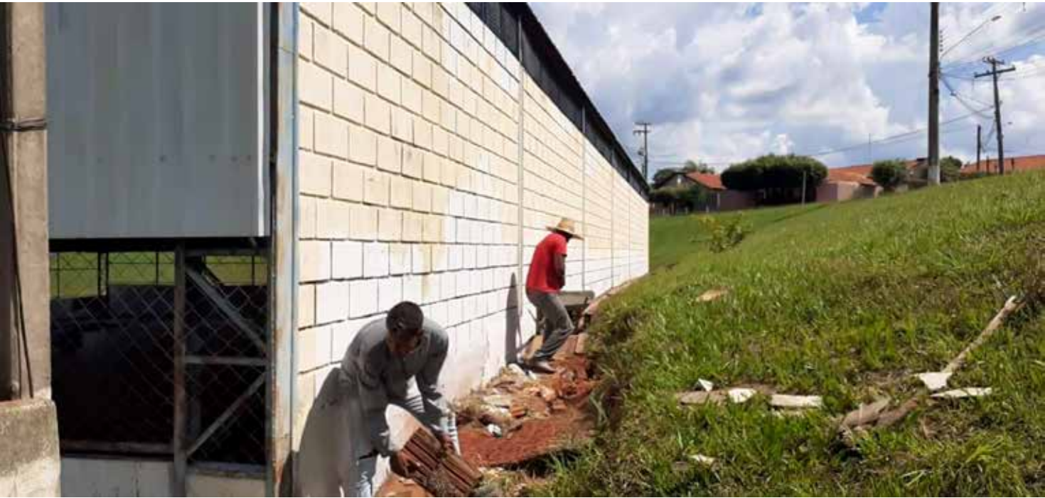
O local já tem 20% dos serviços concluídos
