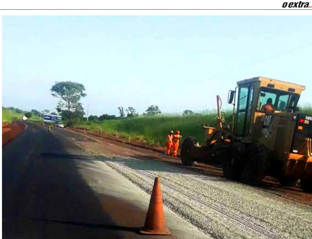
Imagens revelam o andamento das obras de recapeamento da SP-543
