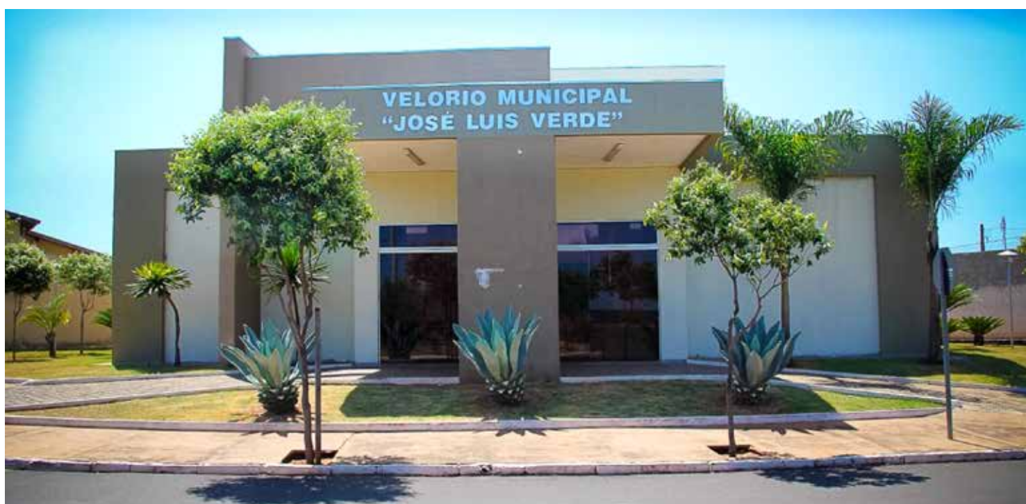
As obras foram realizadas com recursos próprios da administração municipal
