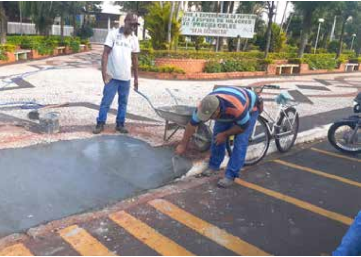
São construídas rampas de acessibilidade na Praça Matriz
