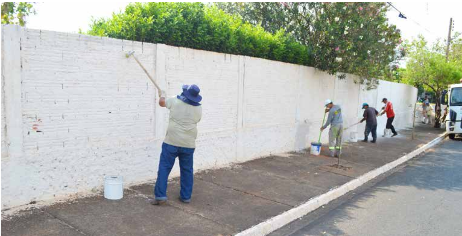
Trabalhadores da Prefeitura pintam os muros do Cemitério
