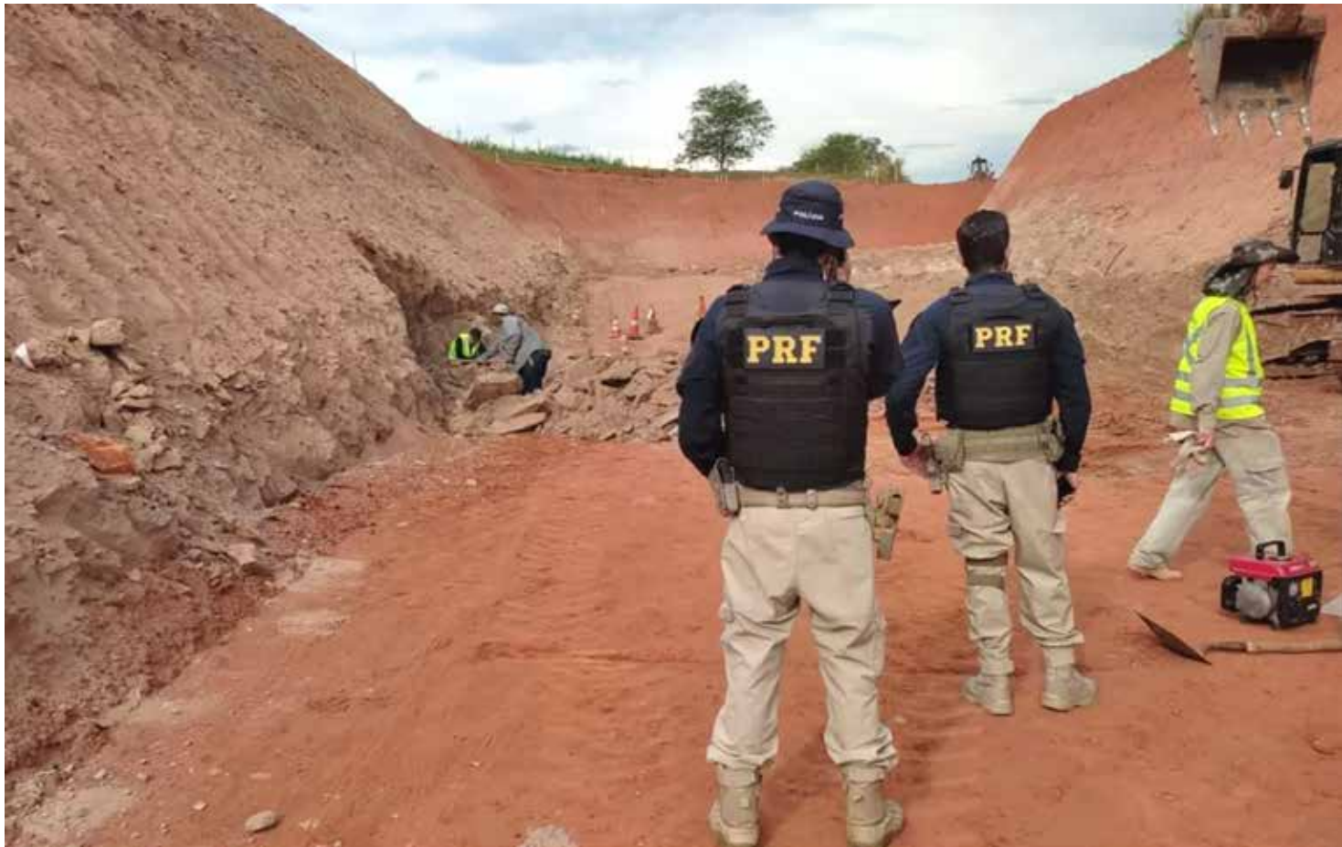
A Polícia Rodoviária Federal acompanhou as escavações, a fim de proporcionar a segurança necessária aos especialistas que trabalhavam no local
