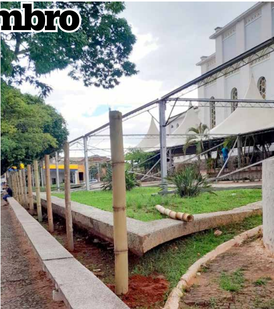
Instalações ficam ao lado da Praça da Matriz
