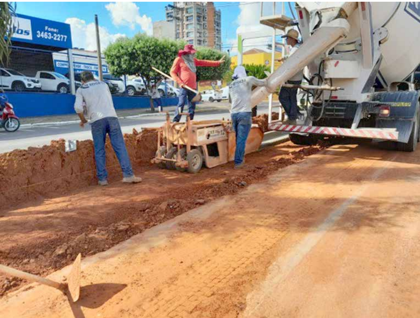
Operários trabalham na área central de Fernandópolis.
