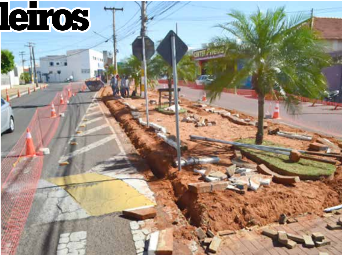
Obras tiveram início no ‘Trecho da Munheca’: R$ 1,1 milhão em investimentos
