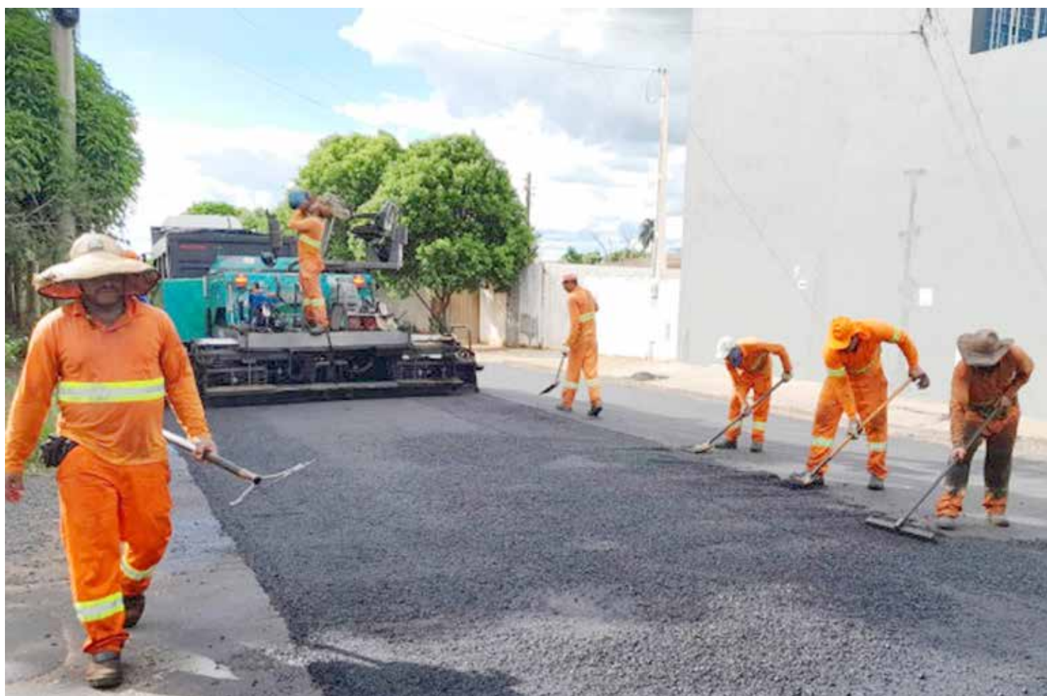
Operários trabalham no recapeamento da Rua Pernambuco
