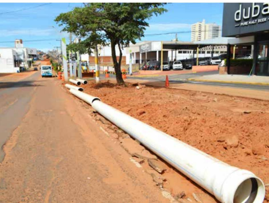
O novo sistema de captação possui tubulação com diâmetro maior, novos pontos de recebimento de água e um melhor escoamento
