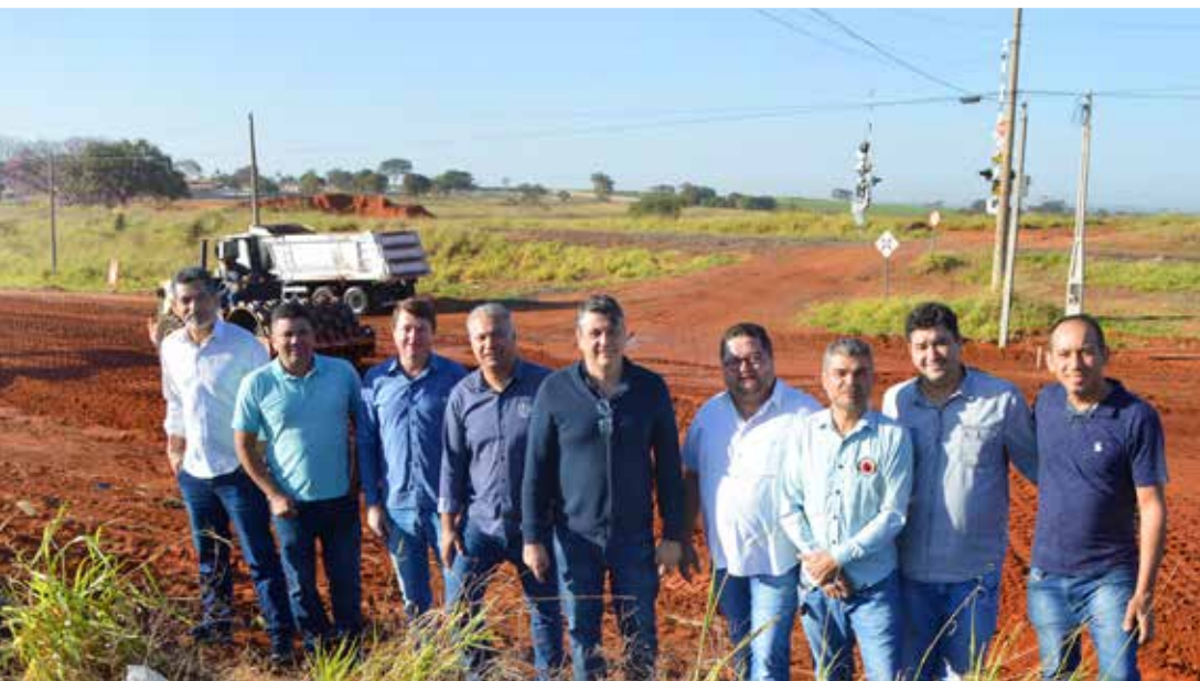
Prefeito e vereadores durante inspeção à obra de duplicação
