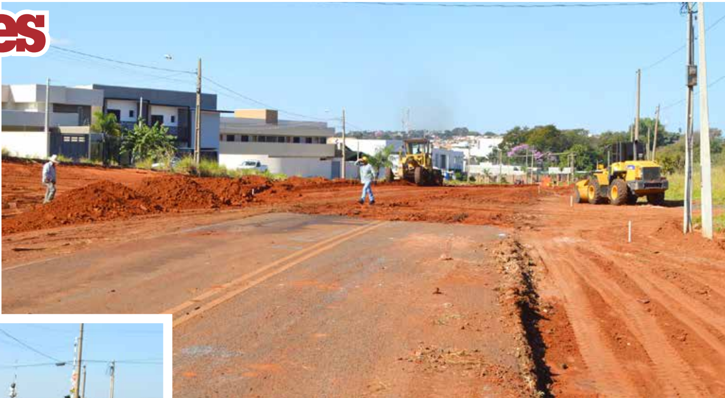
Operários trabalham na nova via: investimento na obra é de R$ 5,3 milhões
