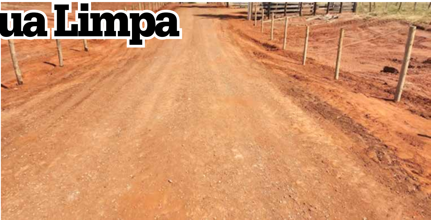
Foram realizadas a quebras de barrancos, lombadas com terraços para escoamento de águas
