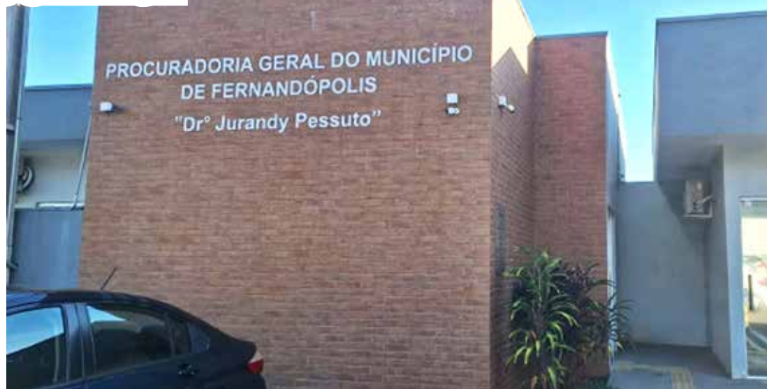
Sede da Procuradoria Geral de Fernandópolis
