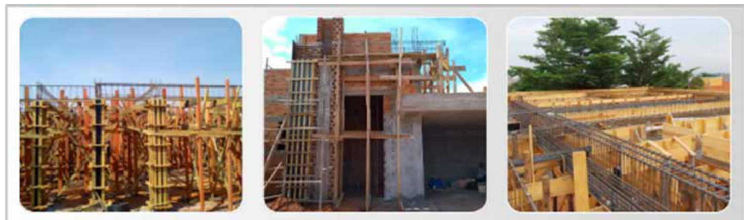
Obras em execução pela empresa certificada pelo PBQP-H e ISO 9001
