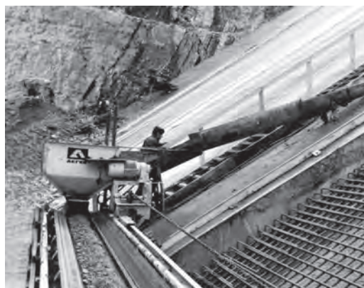
FIG. 12.28 Colocação do concreto com correia transportadora
