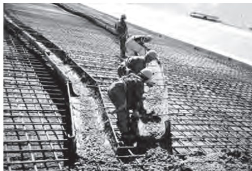
FIG. 12.27 Colocação do concreto com calhas metálicas
