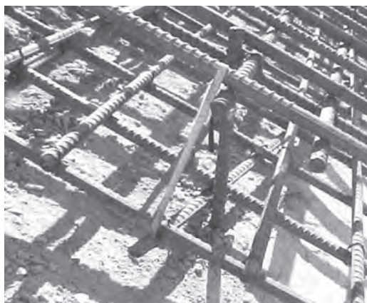
FIG. 3.13 Campos Novos: armadura dupla próxima às ombreiras
