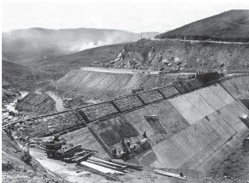
FIG. 1.1 Barragem Saturnino de Brito, 1933 (Cortesia do Eng. Cícero M. Moraes)
