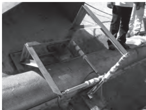
FIG. 9.14 Medidor triortogonal na barragem de El Cajón
