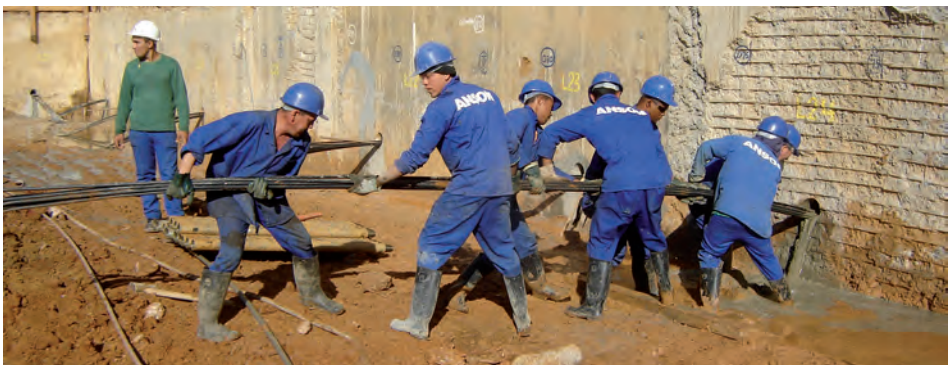
Fig. 2.23 Colocação do tirante de cordoalha na perfuração
