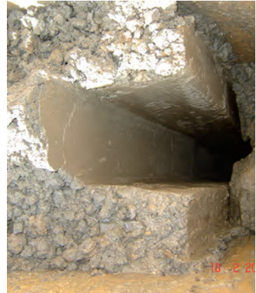
Fig. 2.20 Retirada do perfil junta e da chapa espelho
