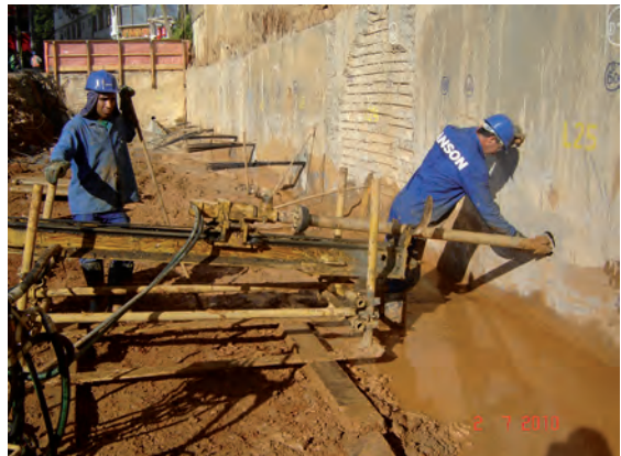
Fig. 2.22 Execução do tirante
