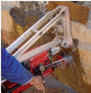
Fig. 2.21 Perfuração do concreto da parede diafragma para a instalação dos tirantes
