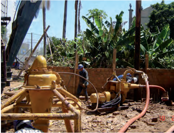
Fig. 2.19 Bomba e desarenador para retorno e tratamento da lama
