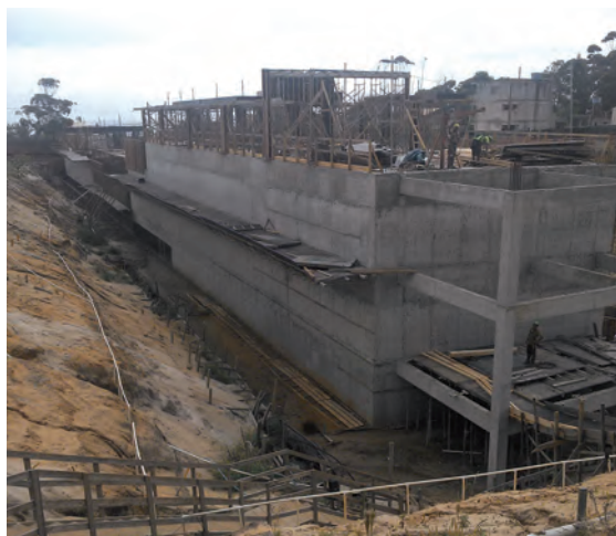
Fig. 2.2 Obra em implantação com solução num dos alinhamentos em talude e estrutura de contenção em concreto armado convencional vinculada à estrutura
