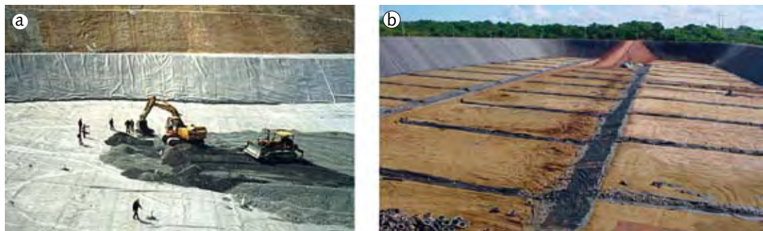
Fig. 5.14 Configuração da camada drenante (brita) no fundo da célula: (a) tapete; (b) espinha de peixe Fonte: Ferrari, 2005.
