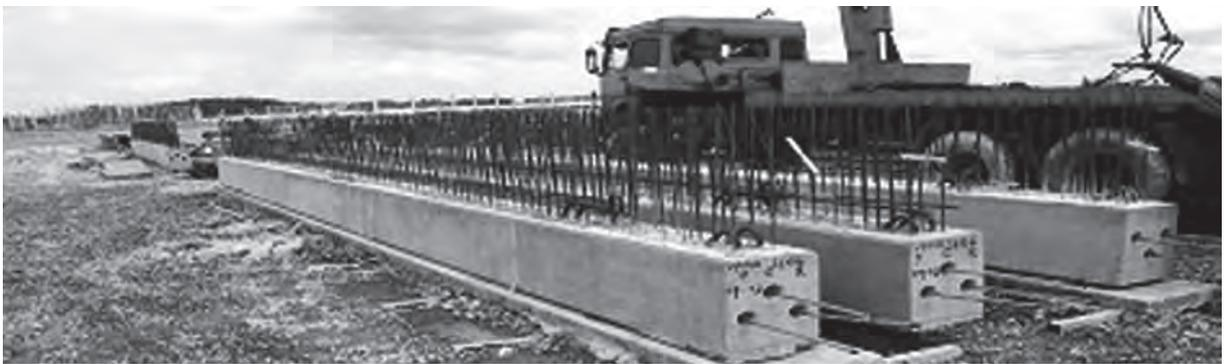
**Figura 42:** Viga pré-moldada protendida: PEÇAS JÁ CONCRETADAS. Obra: fábrica de pneus Continental – Automóveis e Caminhões. Projeto de Statura Engenharia e Projetos. Execução: Camargo Corrêa. Peças já concretadas aguardando a protensão.
