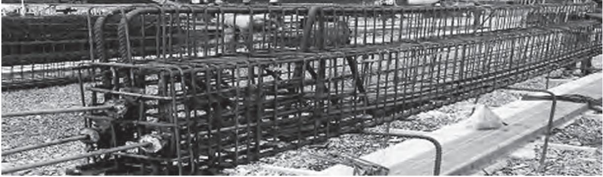
**Figura 41:** Viga pré-moldada protendida: pós-tração – ARMADURAS PREPARADAS. Obra: fábrica de pneus Continental – Automóveis e Caminhões. Projeto de Statura Engenharia e Projetos. Execução: Camargo Corrêa. Armaduras ativas com cordoalhas engraxadas.
