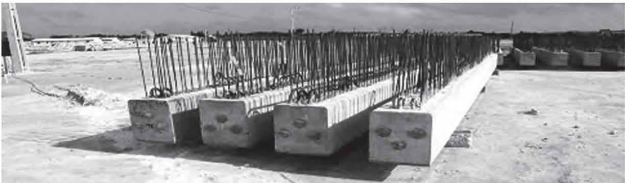
**Figura 43:** Viga pré-moldada protendida: pós-tração – PEÇAS PROTENDIDAS PRONTAS. Obra: fábrica de pneus Continental – Automóveis e Caminhões. Projeto de Statura Engenharia e Projetos. Execução: Camargo Corrêa. Peças já prontas aguardando a montagem.
