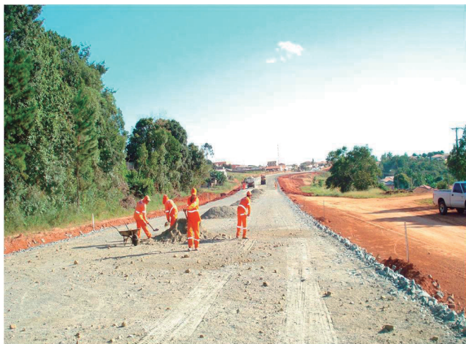
Foto 45 - Espalhamento do material de enchimento
