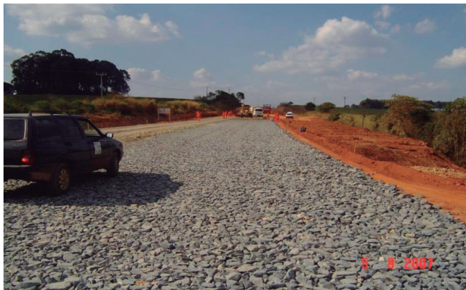
Foto 44 - Espalhamento da camada do agregado graúdo
