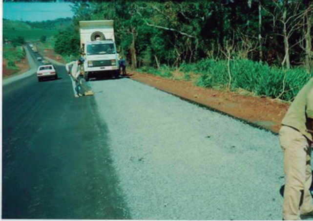
Foto 60 – Espelhamento da camada final de acabamento
