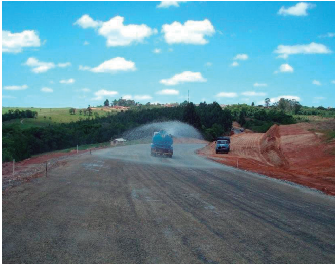
Foto 46 - Irrigação do material de enchimento
