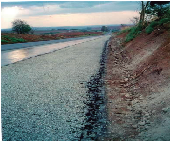
Foto 59 - Segunda camada sobre o primeiro banho
