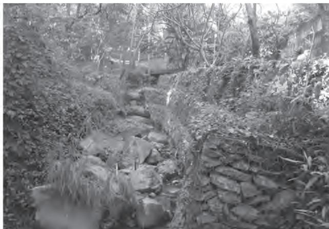
**FIG. 11.15** Exemplo de aplicação de gabiões vegetados em margens fluviais. Parque Urbano do Córrego Baleares, Belo Horizonte (MG)
