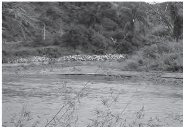
**FIG. 11.16** Exemplo de aplicação de estrutura do tipo *rip rap* ao longo de margens fluviais. Rio Doce, Município de Barra Longa (MG)
