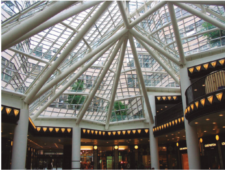
Figura 1.2 Estrutura do telhado do centro comercial Quartier 206, em Berlim. Uma estrutura de telhado bastante “musculosa”!
