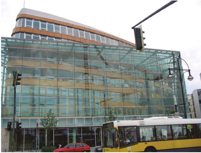
Figura 1.4 Um edifício convencional envolvido por uma estrutura externa envidraçada. As duas estruturas parecem ser completamente independentes uma da outra.
