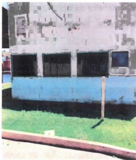
Janelas com grades.
