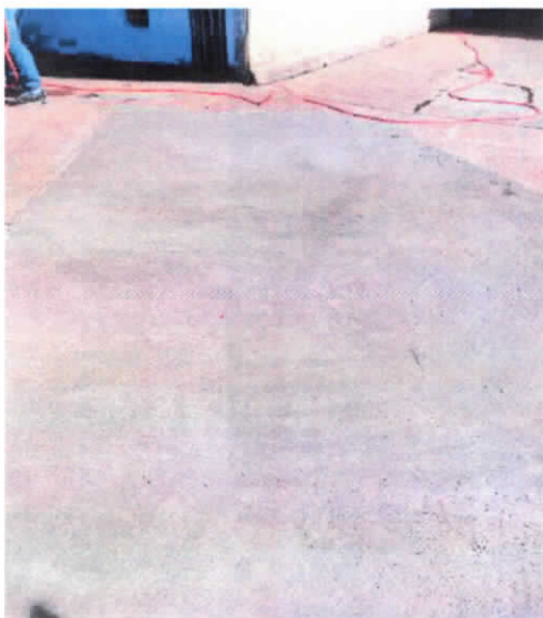
Reparo no Piso
