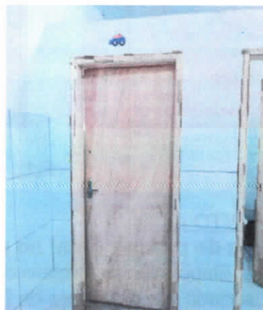
Porta interna banheiro Masc.
