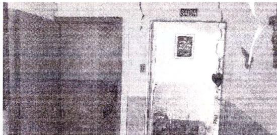
**Padaria:** Piso cerâmico em todas as áreas, paredes parcialmente revestidas em azulejos e pintura, esquadrias internas em madeira, instalações elétricas e hidráulicas embutidas nas paredes e forros.
