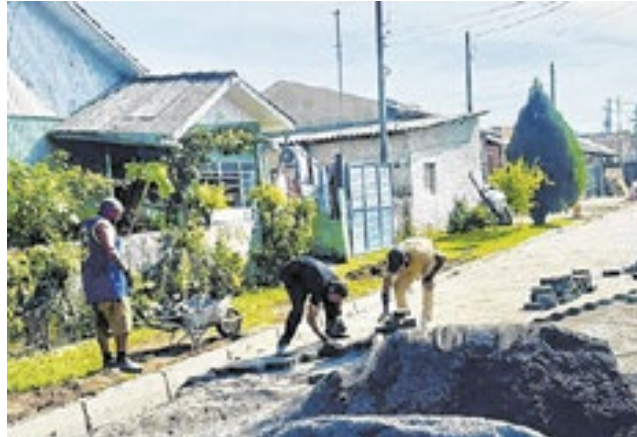
Obra de calçamento na Rua João Altenhofen
