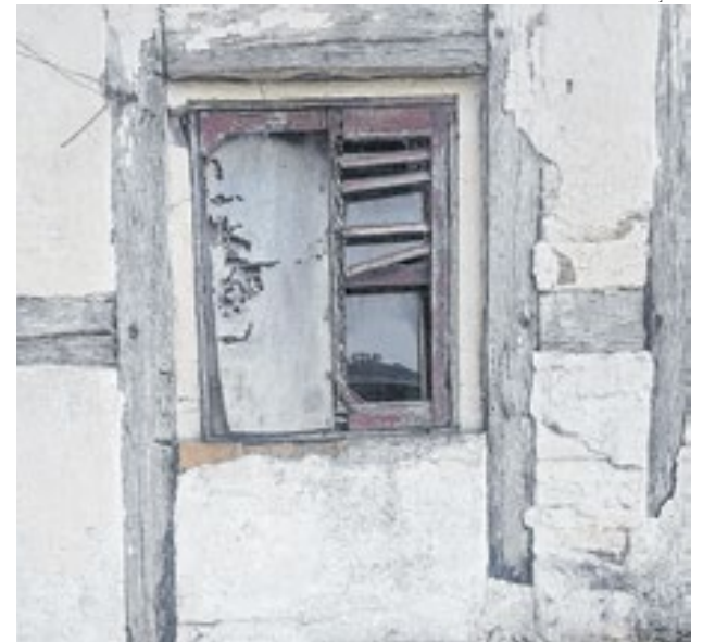
Exemplo da deterioração a que estão sujeitas as construções em enxaimel, que é um dos focos do projeto desenvolvido pelos arquitetos
