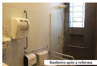
Banheiro após a reforma
