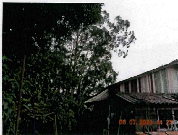
...Nota-se na imagem que os eucaliptos estão bem próximos e inclinados sobre as construções na divisa.
