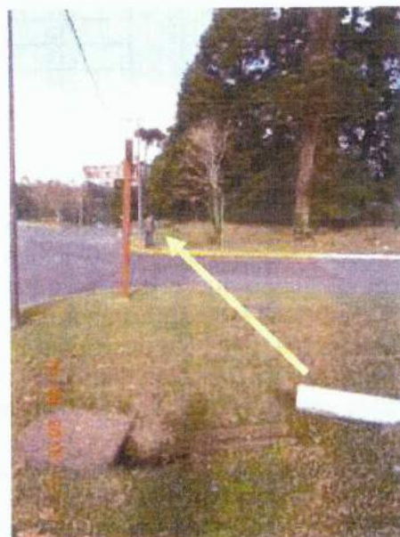
Foto 4. Sentido do fluxo d'água que sai do dreno.
